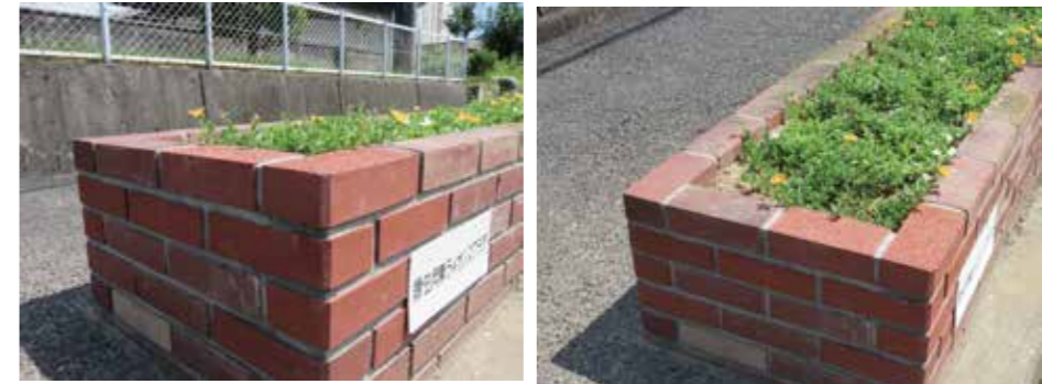
8月中旬 修復完了 市役所より連絡
